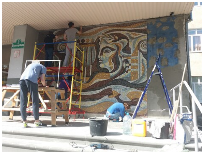
Реставрация мозаики "Вдохновение" у главного входа в колледж
