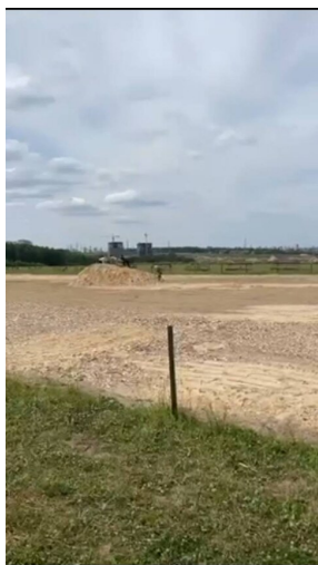
Привезен песок, необходимый для подготовки грунта
