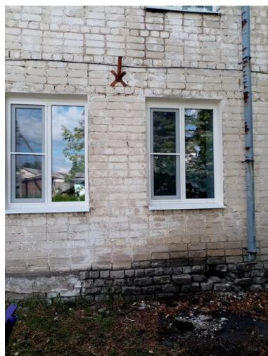
Окна помещения после ремонта. Варнавино, ул.Красноармейская, д.1а, 23.06.2023
