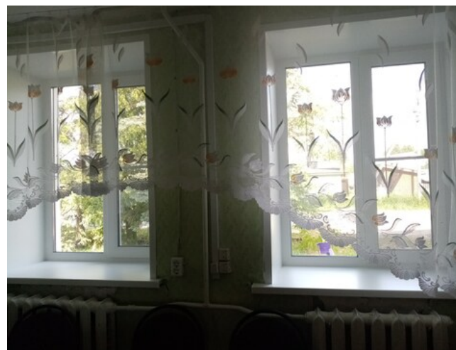
Окна помещения после ремонта. Варнавино, ул.Красноармейская, д.1а, 23.06.2023
