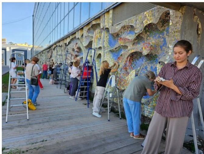
Процесс реставрации 15 сентября 2024 г.
