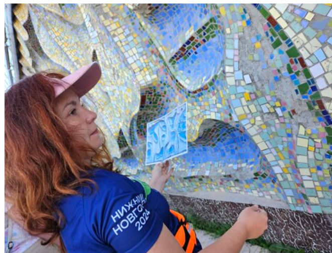
Процесс реставрации 14 сентября 2024 г.
