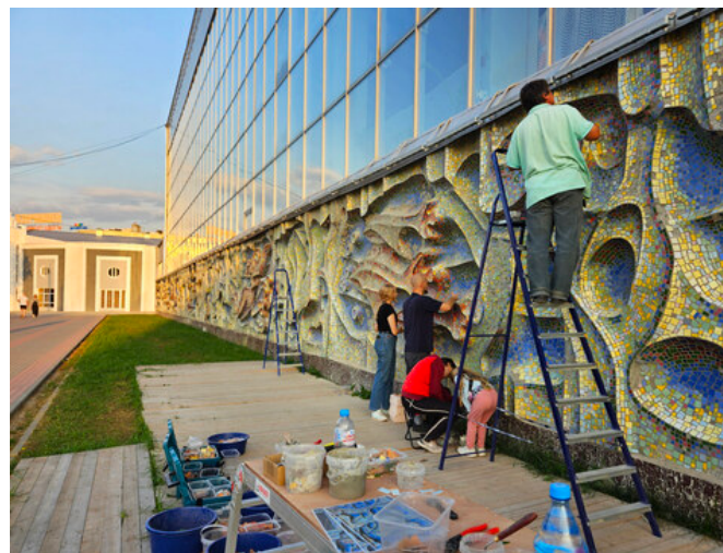
Процесс реставрации 18 сентября 2024 г.
