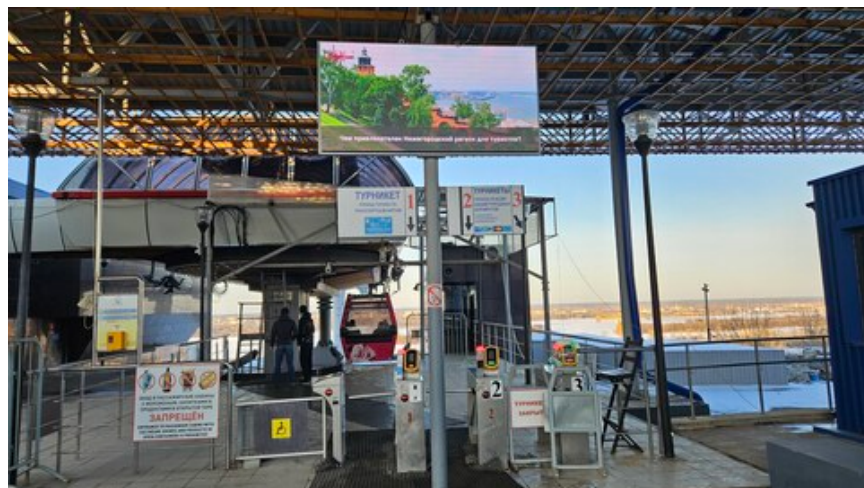
Размещение роликов на канатной дороге
