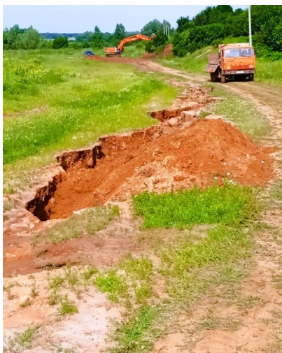
Гоночная трасса в с. Кожино г.о.г. Арзамас до планировочных и отсыпных работ, начало июня 2024 г.
