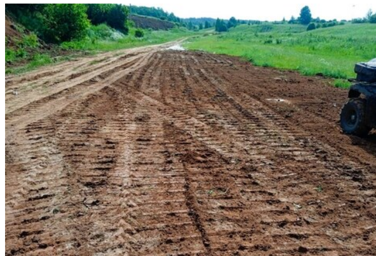
Гоночная трасса в с. Кожино г.о.г. Арзамас после планировочных и отсыпных работ, конец июня 2024 г.
