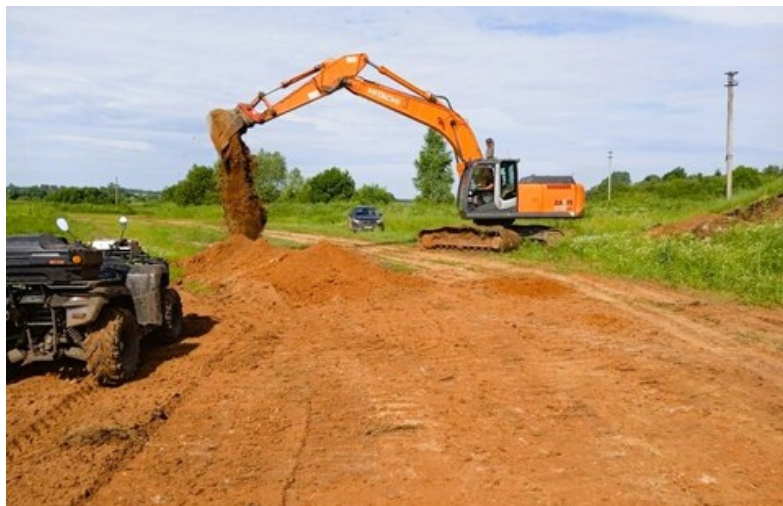
Планировка и отсыпка гоночной трассы
