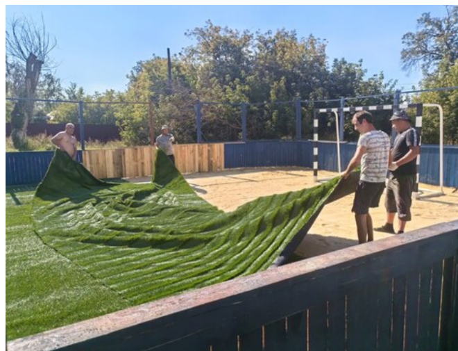
Укладка искусственного покрытия
