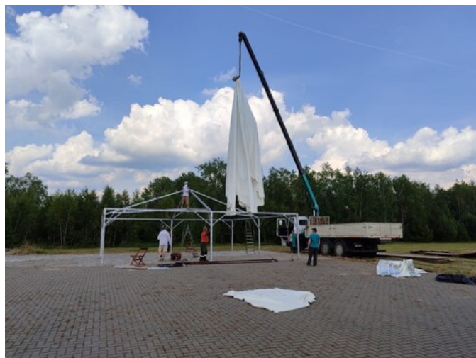
установка большого шатра для проведения спектаклей, лекций
