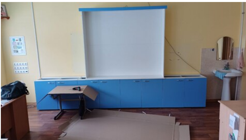
Установка мебели 7 ноября
